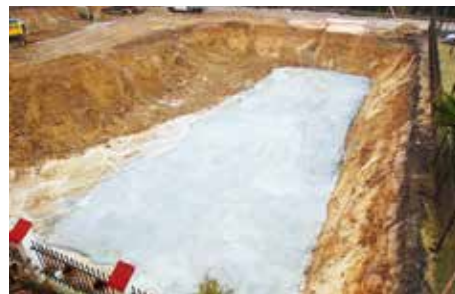
Plac budowy przy Ryżowej
